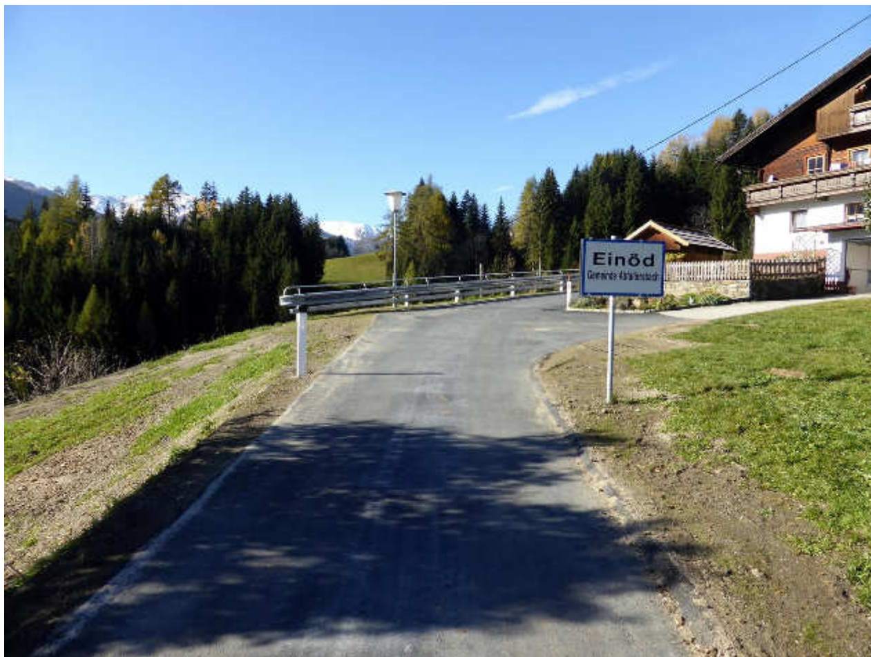
Generalsanierte Ortsdurchfahrt Einöd
