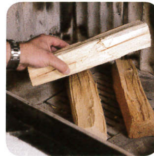
Das Holz locker in den Brennraum schichten.
